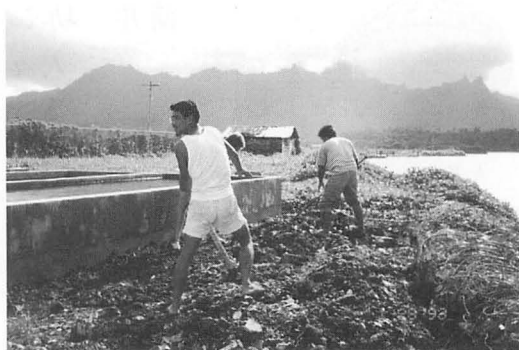
図4：草地を整地し、手作り水槽の設置準備
