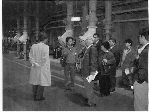
エクスカーショ風景 - 熱供給システム
