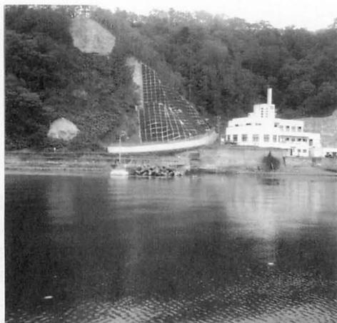
図2 厚岸臨海実験所地先の船着場の防波堤と消波ブロック
